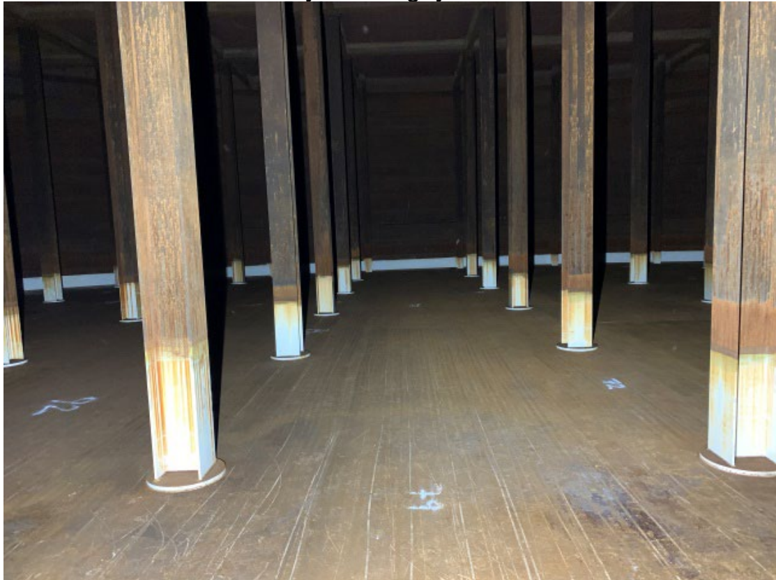
Mynd 1. Gólf og umfar geymis.
