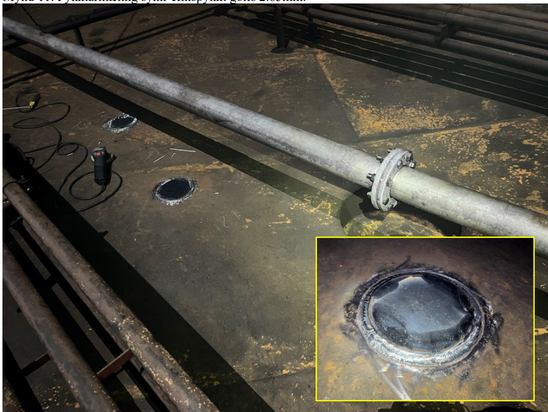
Mynd 12 og 13. Samtals 5 hringlaga plattar vorðu soðnir við gólf.
