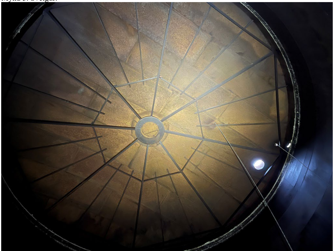
Mynd 4. Þak geymis.
