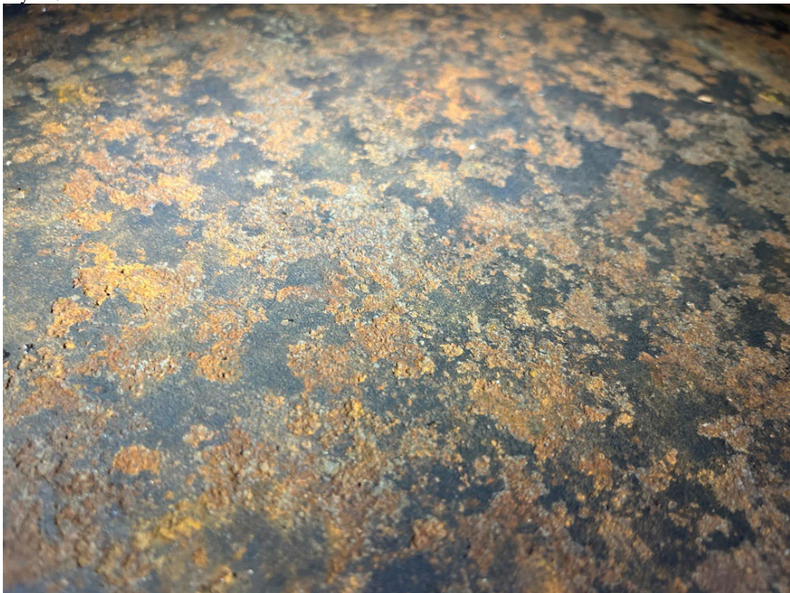
Mynd 8. Gólf er alsett tæringu.
