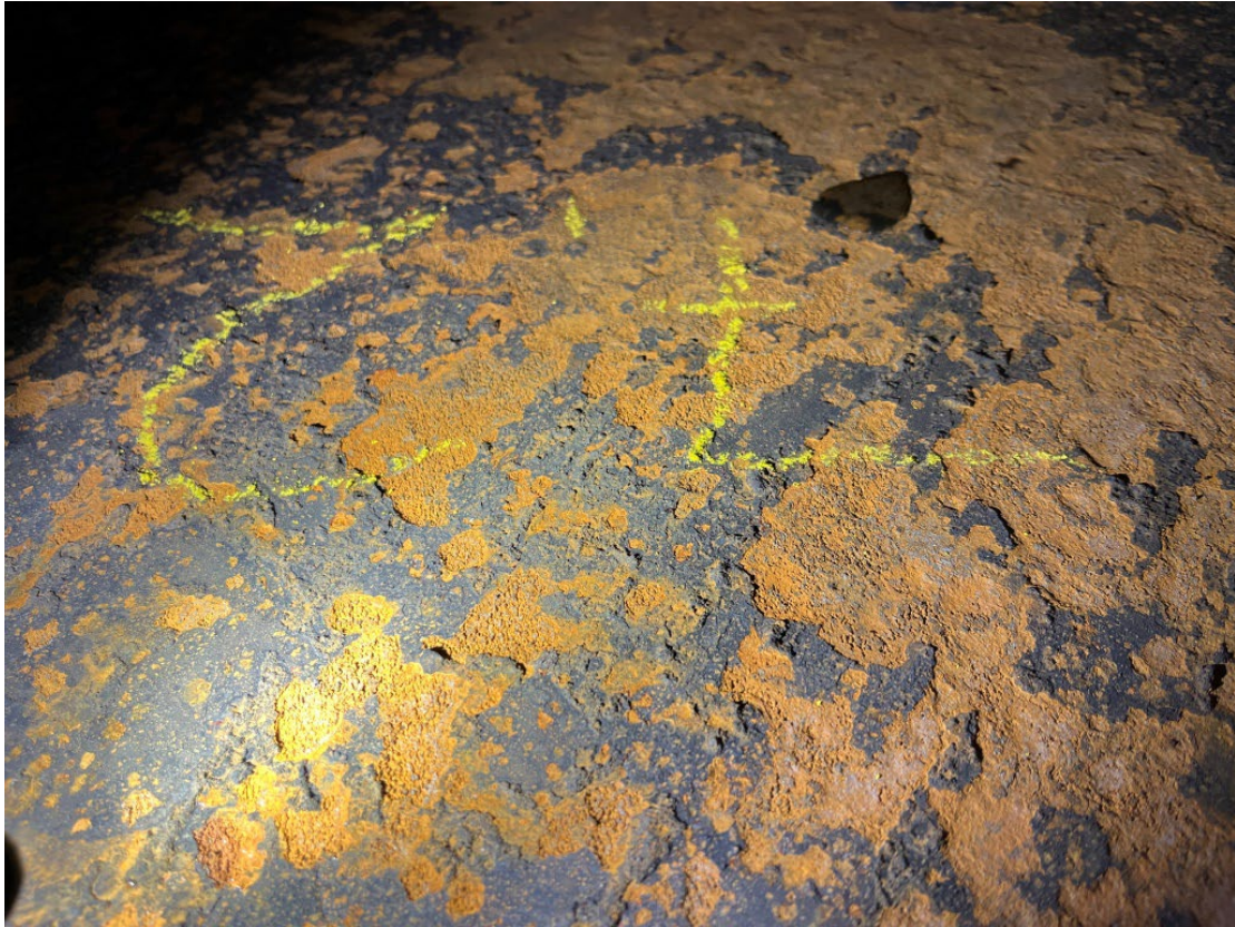
Mynd 9. Gólf er alsett tæringu.
