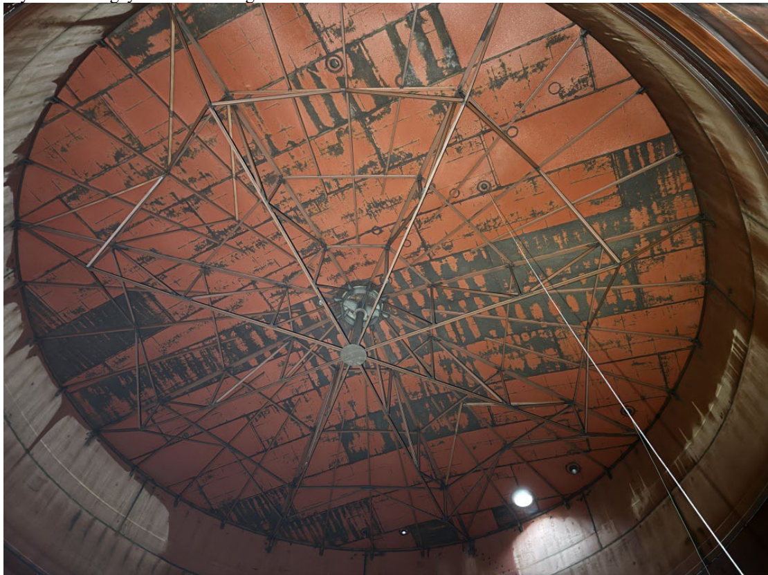
Mynd 6. Þak geymis.
