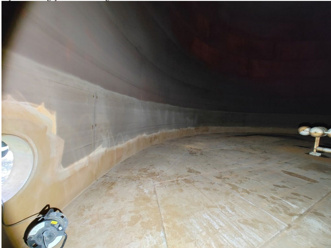
Mynd 2. Neðsta umfarið lítur vel út og hefur verið endurnýjað við kverk.
