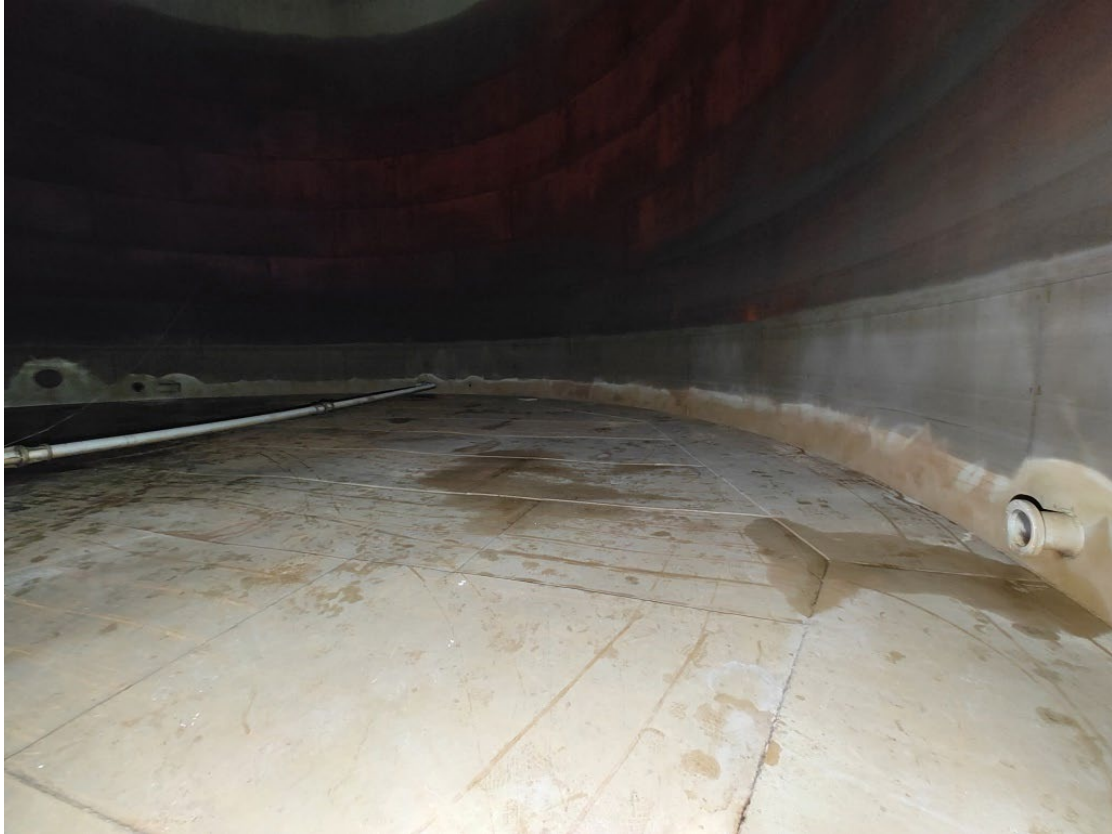
Mynd 3. Neðsta umfarið lítur vel út og hefur verið endurnýjað við kverk.
