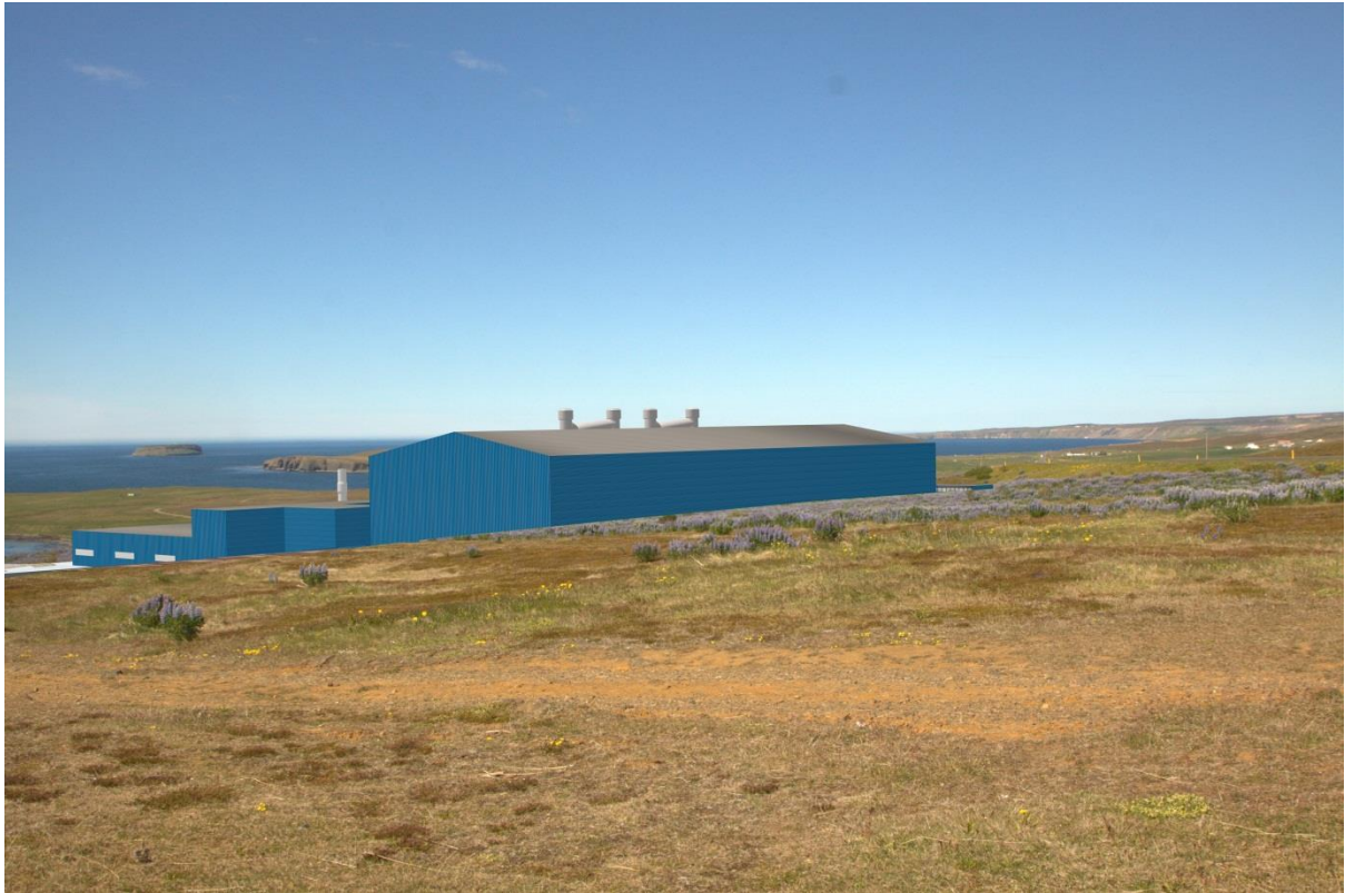
Mynd 46: Horft frá Gónhól, 1. áfangi. Sjónarhorn 4 á mynd 34 (Ljósmynd PCC SE).
