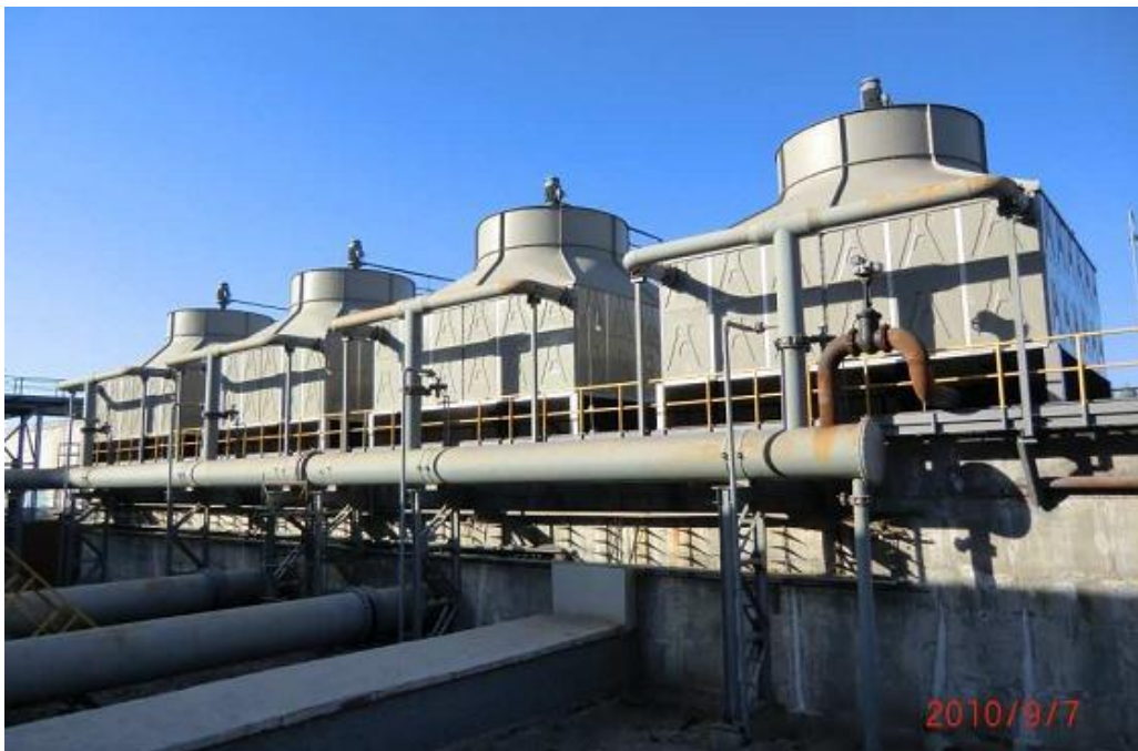
Mynd 8: Kæliturnar með kæliviftum (Mynd SMS Siemag).
