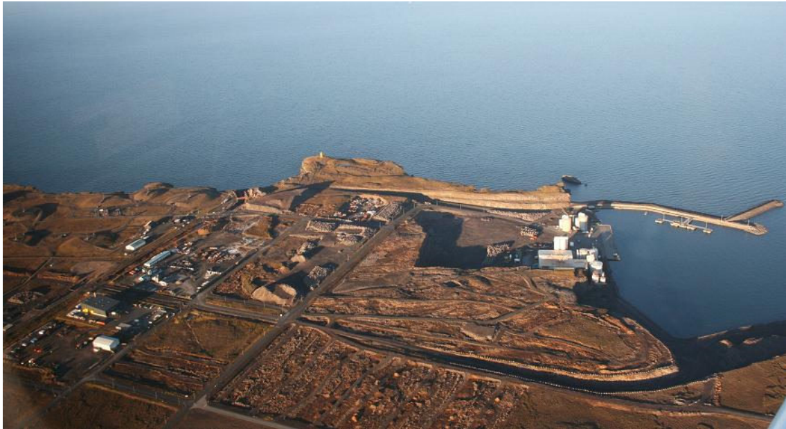
Mynd 2.1 Helguvíkurhöfn, Stakksbraut 9 og hluti iðnaðarsvæðis
