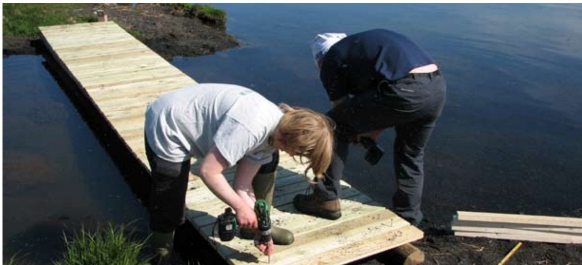
Unnið að smíði göngubrúar yfir Skipalæk.
