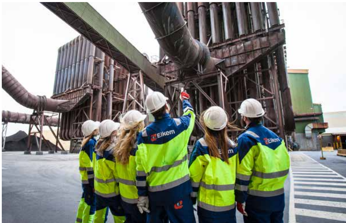
Reykahreinsivirki Elkem Ísland. Árlega fanga virkin um 20.000 tonn af kísilryki sem notað er sem íblöndunarefni í sement.
