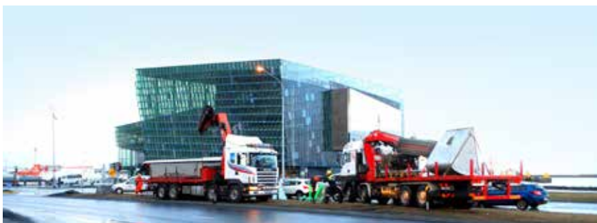
Mynd 26. Unnið að því að setja nýja neyðarlúgu í dælustöðina við Ingólfsstræti í Reykjavík. Ljósmynd: Hildur Ingvarsdóttir.
