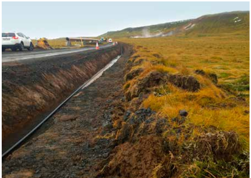
Mynd 5a. Meðan á framkvæmdum stóð voru gróðurtorfur teknar upp úr skurðstæði við Hverahlíð og lagðar á skurðbarm. Ljósmynd: Magnea Magnúsdóttir.
