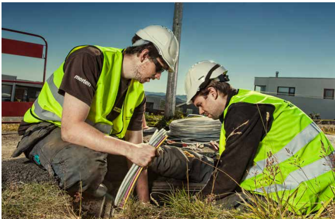
Mynd 15. Unnið við lagningu ljósleiðara í Hafnarfirði. Ljósmynd: Sigurjón Ragnar.
