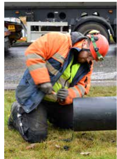
Mynd 2. Unnið við lagningu vatnsveitu í Reykjavík. Ljósmynd: Hildur Ingvarsdóttir.
