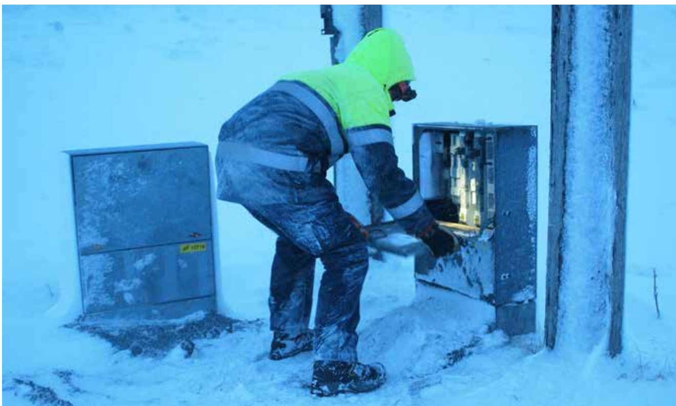
Mynd 9. Unnið að tengingu í rafmagnsskáp. Ljósmynd: Hildur Ingvarsdóttir.
