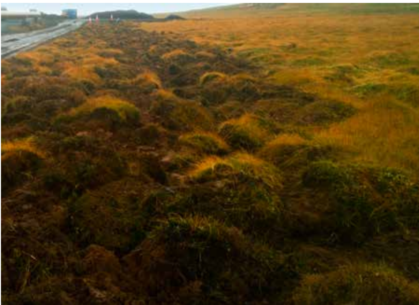
Mynd 5b. Við frágang voru torfurnar lagðar yfir skurðinn til að nýta staðargróður. Þannig er líffræðilegri fjölbreytni viðhaldið, ásamt betri ásýnd og virkni gróðurlenda. Ljósmynd: Magnea Magnúsdóttir.
