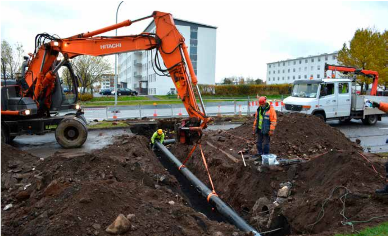
Mynd 13. Unnið að vatnslögn við Kringlumýrarbraut í Reykjavík. Ljósmynd: Hildur Ingvarsdóttir.
