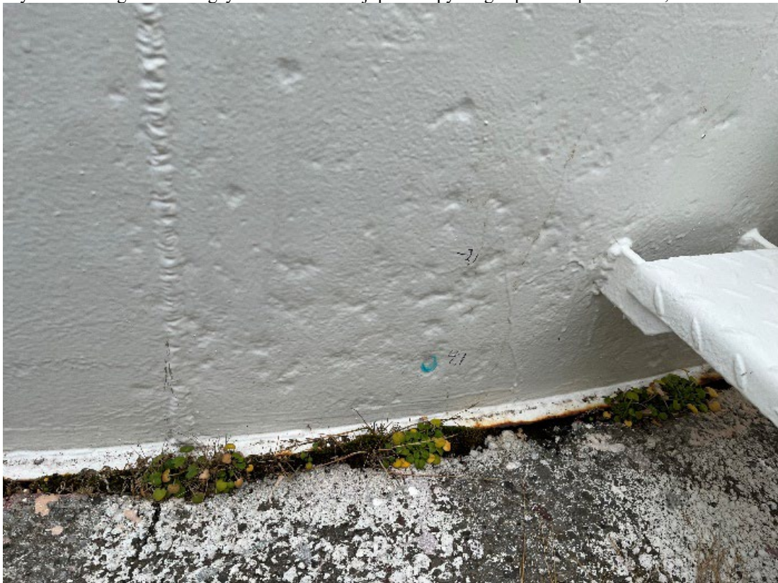
Mynd 9. Ummerki af tæringu frá fyrri tíð sjást vel utan á geymi. Geymir virðist nýmálaður.
