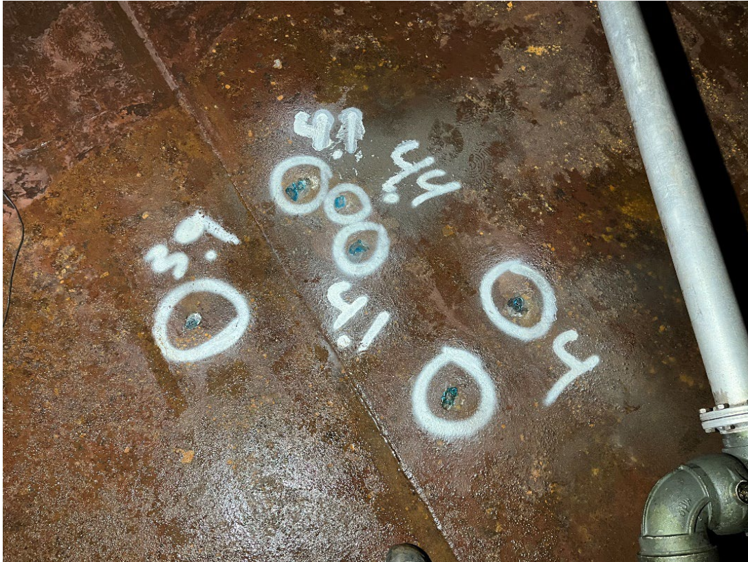
Mynd 2. Við segulskönnun fundust svæði sem gáfu tilkynna efnisþynningu á gólfi geymis. Allir staðirnir voru vel yfir viðmiðunarmörkum.
