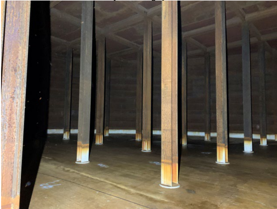
Mynd 1. Gólf og umfar geymis.
