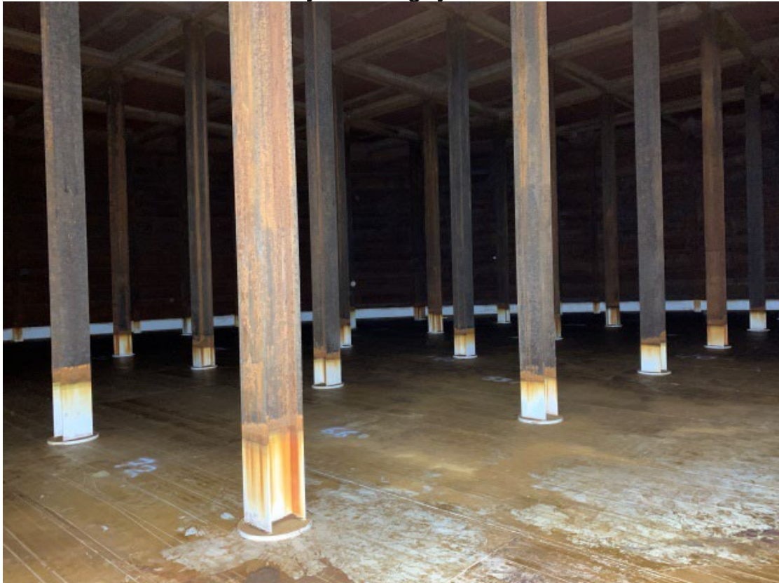
Mynd 1. Gólf og umfar geymis.
