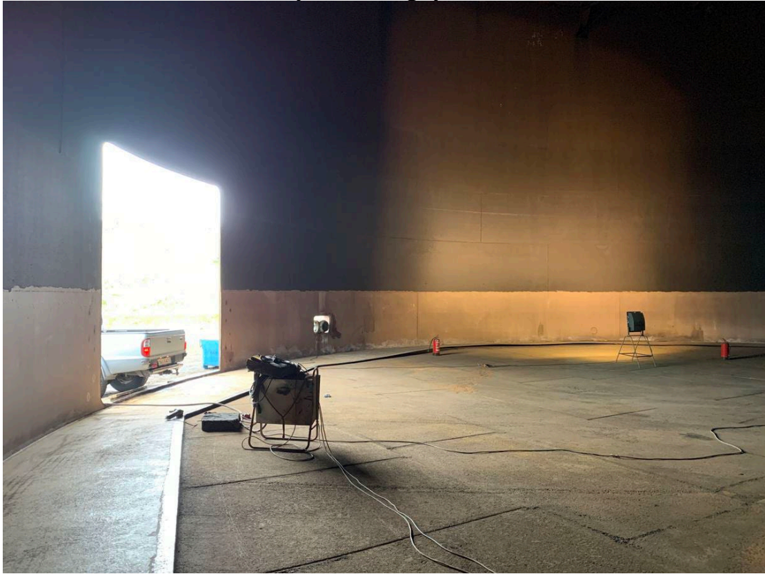
Mynd 1. Búið er að fjarlægja plötunarn sem tengdust hringplötunum.
