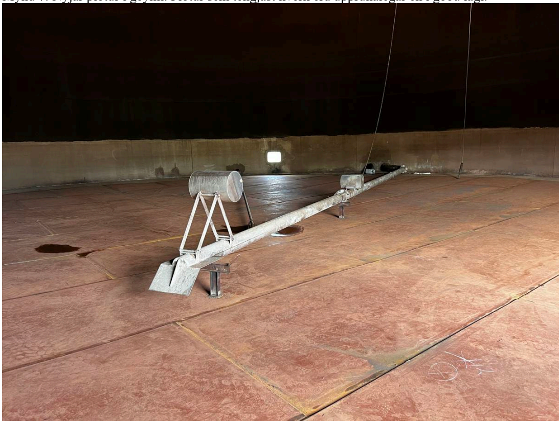
Mynd 8. Vandað hefur verið til verks og litu suður afar vel út.
