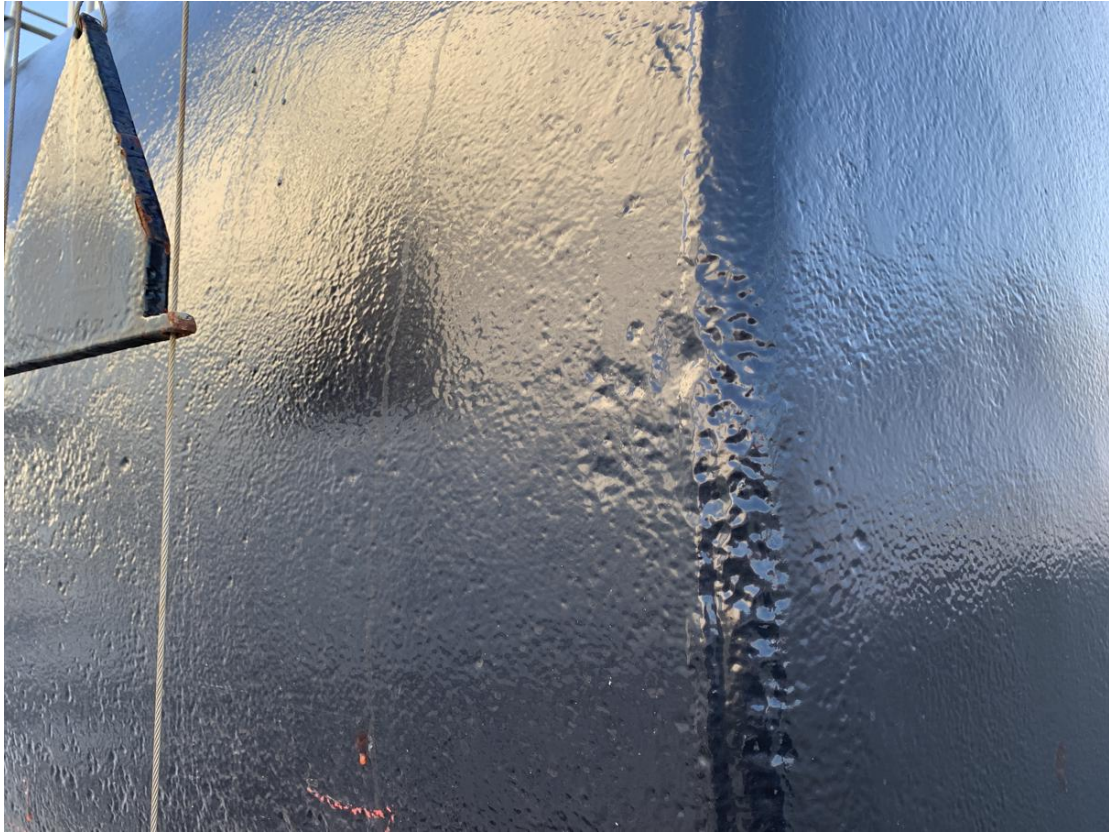
Mynd 2. Pyttir eru yfirleitt minniháttar en þó má finna á stöku stað 3-4mm djúpa pytti.
