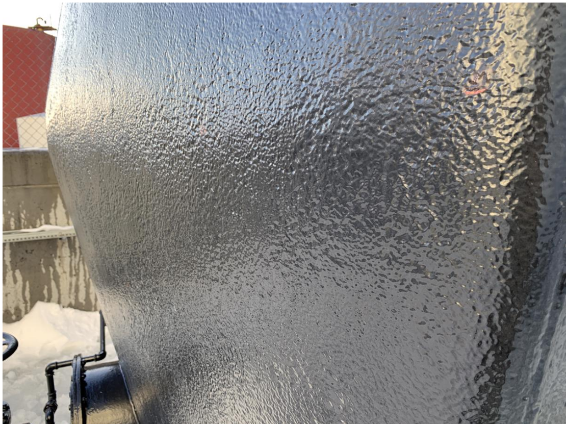
Mynd 1. Geymir hrjúfur og erfiður til mælingar vegna tæringar frá fyrri tíð.
