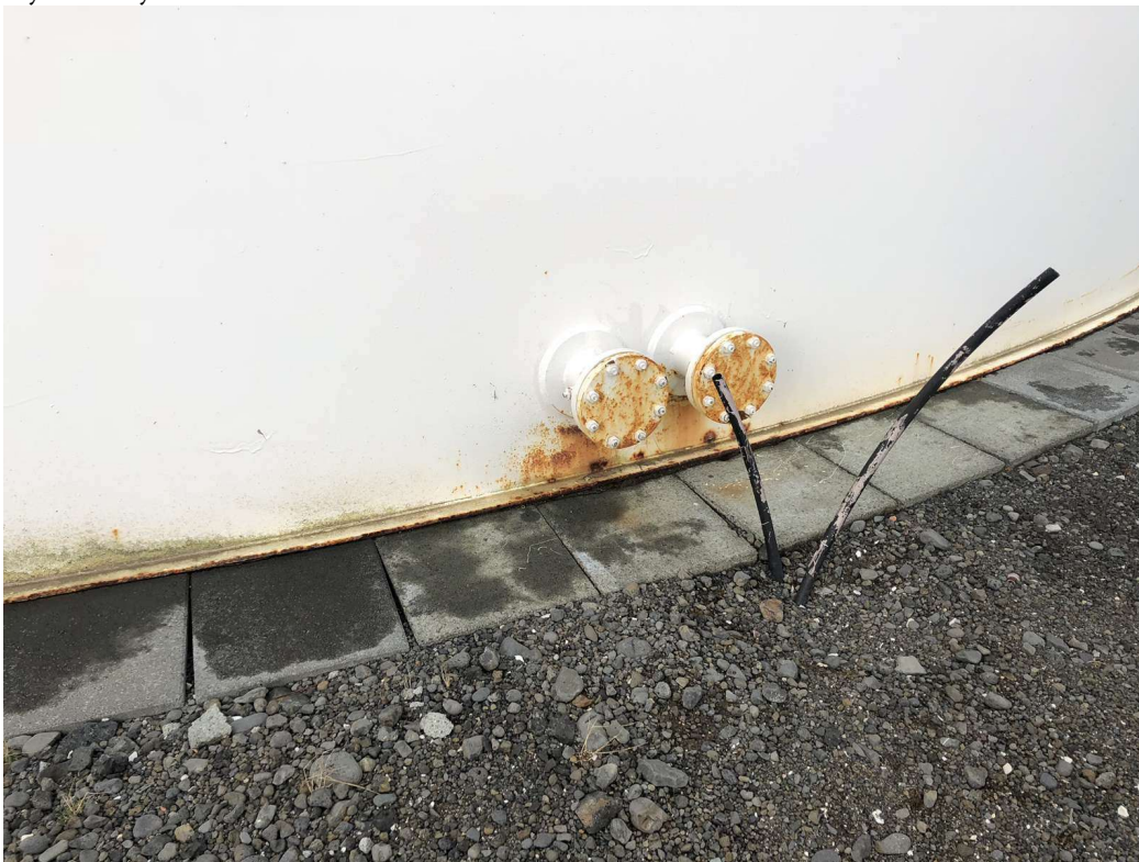
Mynd 6. Geymir lítur vel út að utanverðu. Einstaka ryðbletti má finna neðarlega á neðsta umfari.
