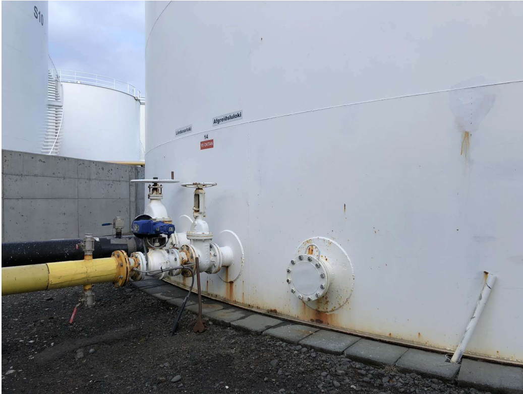
Mynd 5. Geymir lítur vel út að utanverðu.
