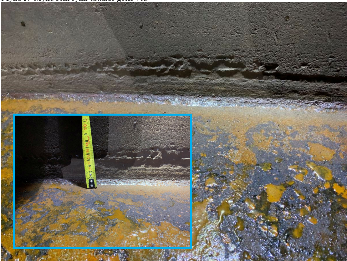
Mynd 6 & 7. Mynd sem sýnir ástand neðsta umfars vel. Minnst mældist umfarið 4mm í c.a. 7,5mm plötu. Innfeld mynd sýnir umfang tæringar eða 70mm frá botni og uppá umfarið.
