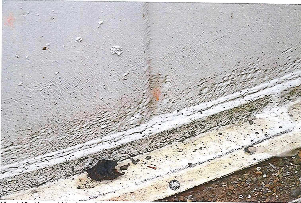
Mynd 13. Ummerki tæringar frá gamalli tíð en hefur nú verið stöðvuð.
