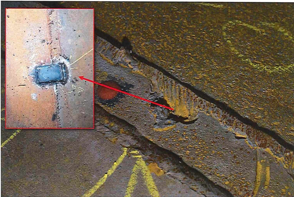
Mynd 11. Djúp hola eftir logskurðartæki. Tvöföldunarplata soðin yfir.
