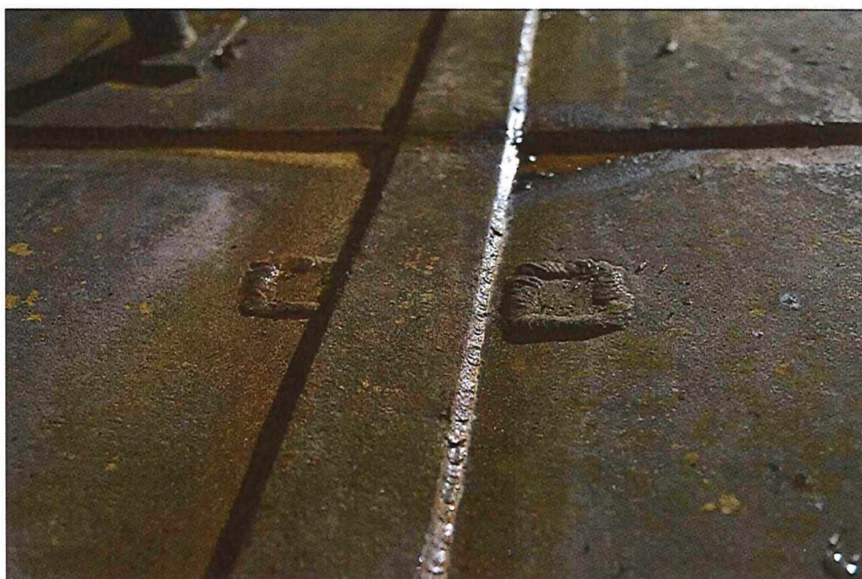
Mynd 10. Víða er búið að sjóða í gólf.
