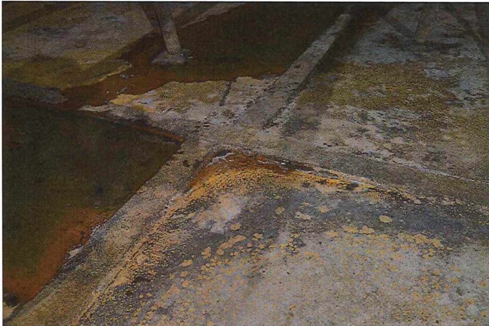
Mynd 5. Flatjárn hafa verið lögð yfir plötusamskeiti.
