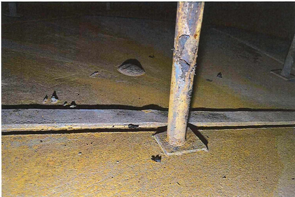
Mynd 8. Plattar fyrir stoðir (spíral) eru ekki heilsoðnir.
