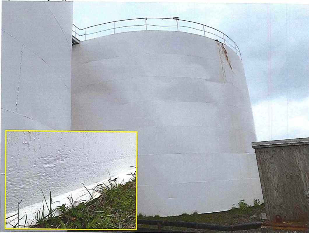
Mynd 7 og 8. Geymir er dældaður og það má sjá tæringu ( Dýpt 0,5-2,3mm ) frá fyrri tíð neðst á geymi.
