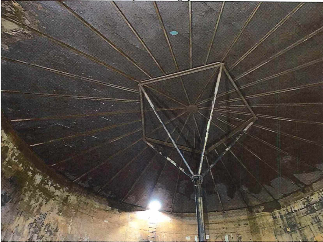
Mynd 1. Þak geymis.
