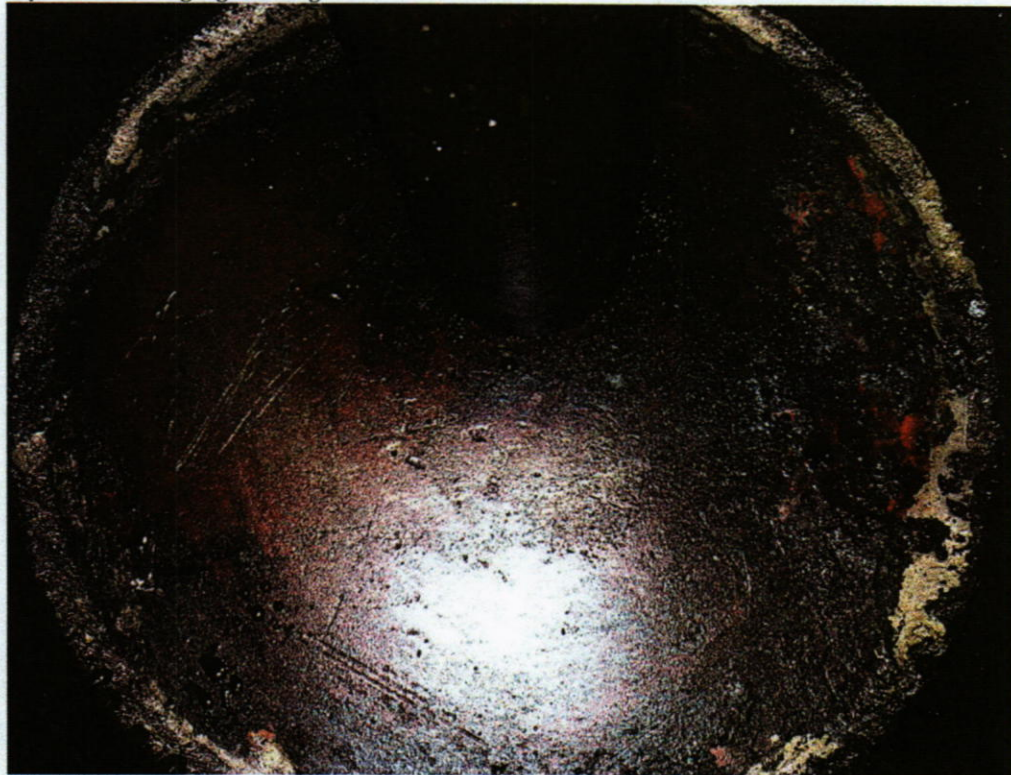
Mynd 6. Svelgur leit ágætlega út að innan.
