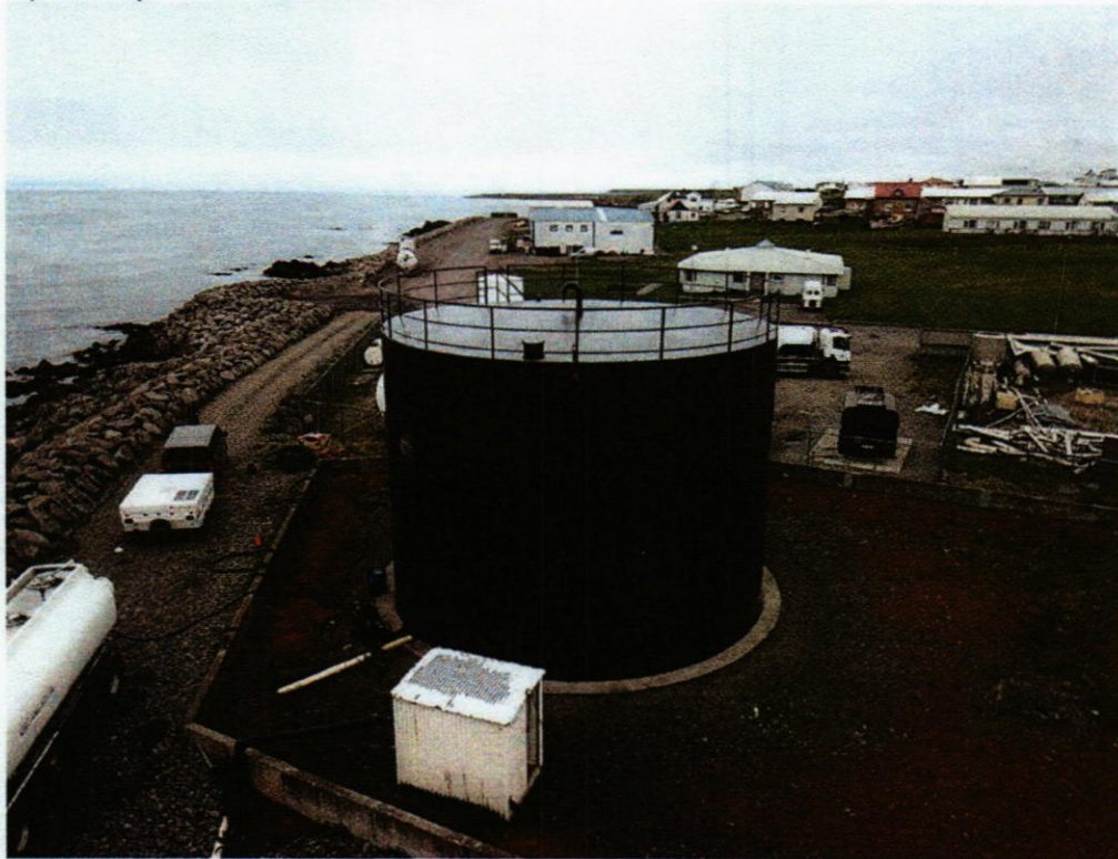
Mynd 8. Geymir lítur vel út að utanverðu.
