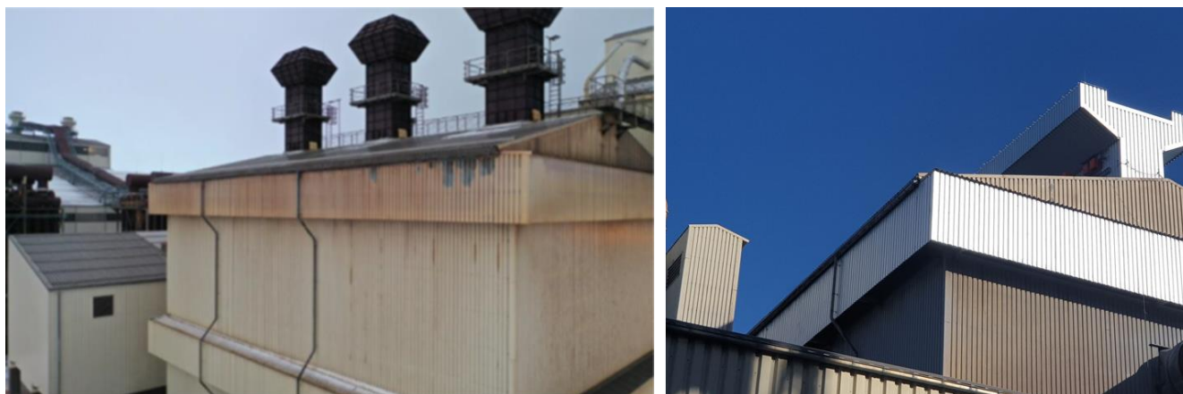
Mynd 4. Breytingar á þaki pokasíuhúss. Áður voru þrjár skorsteinar (vinstri) en nú er einn langháfur (hægri).
