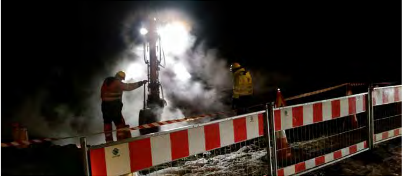
Unnið við hitaveitu í Reykjavík. Ljósmynd: Bjarni Líndal Snorrason.
