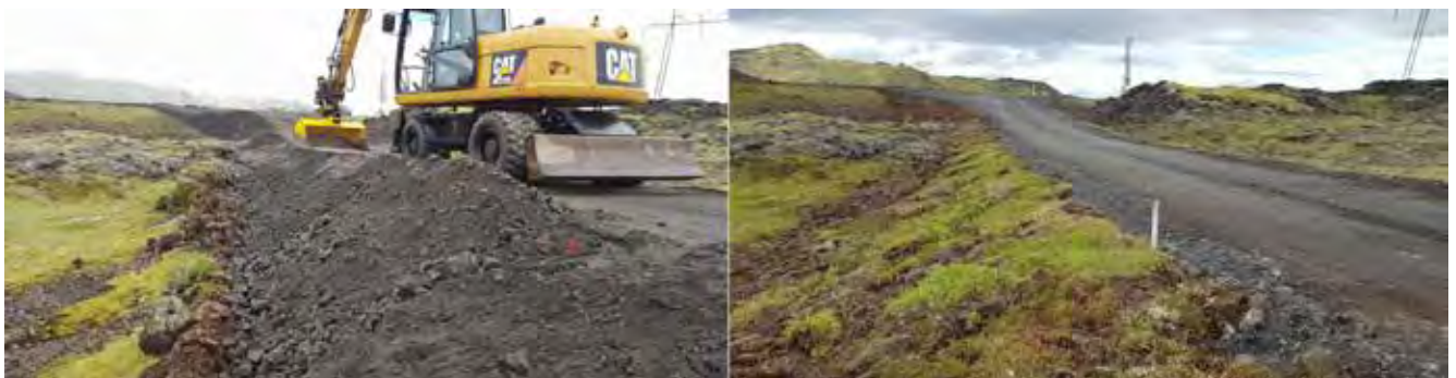
Mynd 3. Endurheimt staðargróðurs. Meðan á framkvæmdum stóð voru gróðurforfur teknar upp úr vegstæði á Hellsheiði og lagðar aftur í vegöxlina. Ljósmynd: Magnea Magnúsdóttir.
