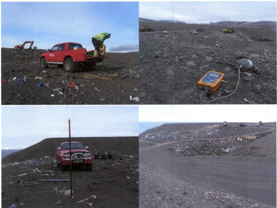
Mynd 2: Niðursetning gasmæliröra og gasmælingar á Stekkjarvík.
