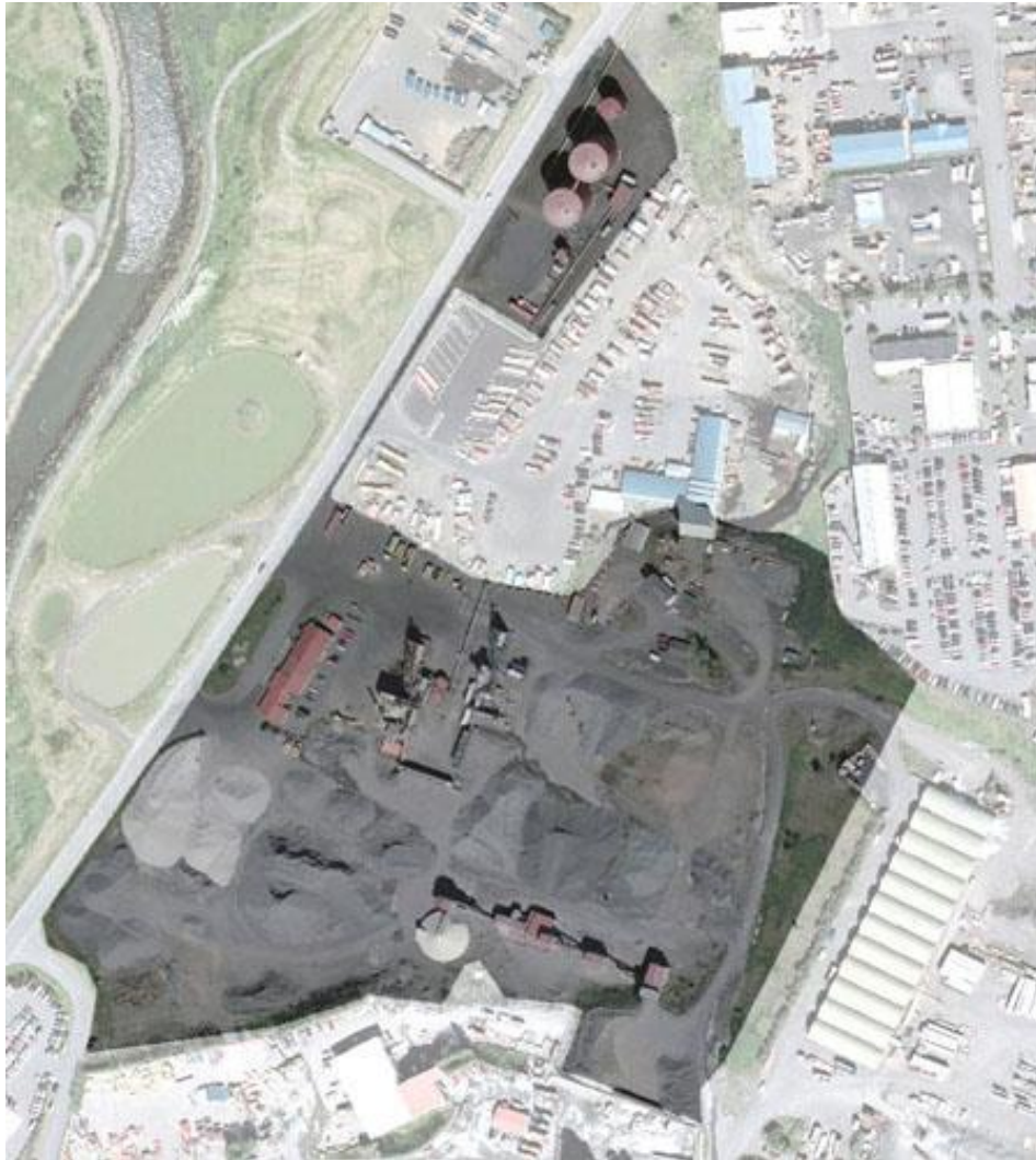
Mynd 1. Yfirlitsmynd af athafnasvæði fyrirtækisins við Sævarhöfða 6-10.
