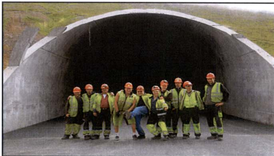
Malbikun Héðinsfjarðarganga lokið haustið 2010
